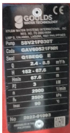
ป้ายชื่อเครื่องสูบน้ำ Jockey/Name Plate
